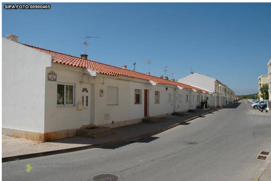
Figura VI.1.57. Conjunto habitacional da Mexilhoeira da Carregação
