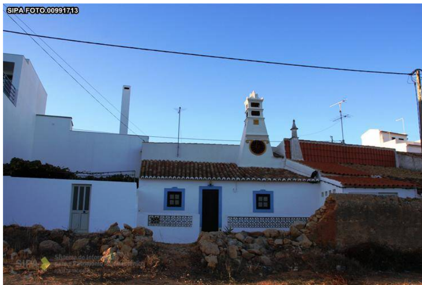
Figura VI.1.50. Casa e chaminé setecentista - aba sul, Porches
