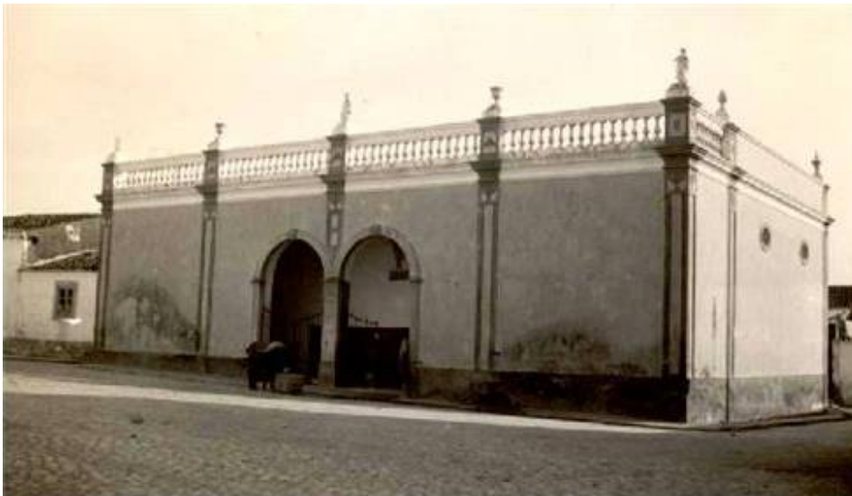
Figura VI.1.66. Fachada do antigo depósito da água
