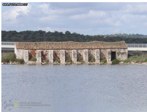
Figura VI.1.56. Moinho de maré em ruínas, Estômbar
