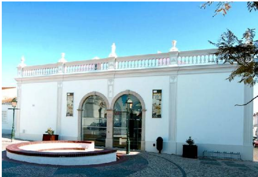
Figura VI.1.67. Fachada do Arquivo Municipal
