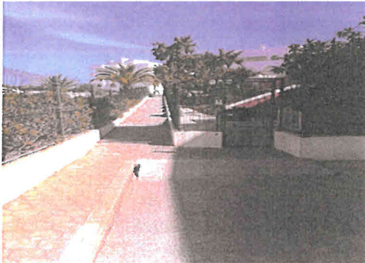
Fotografia n.º14 – Acesso pedonal sobre-elevado e porta de abertura com cartão ou código a fornecer pela unidade hoteleira
