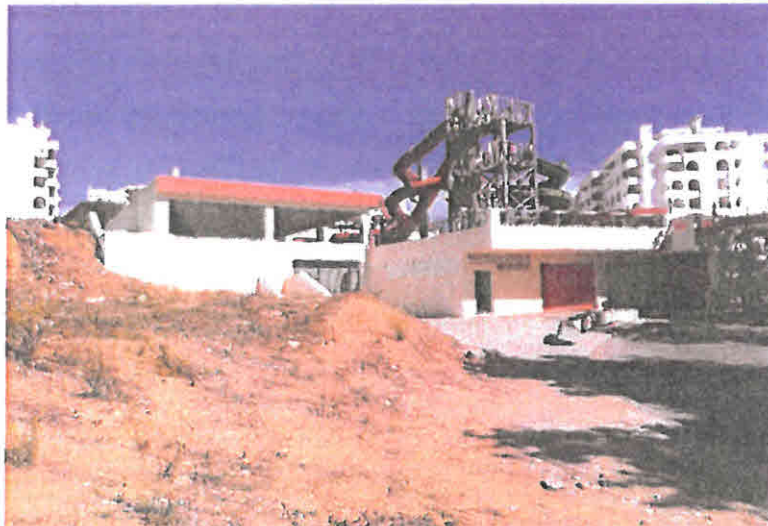
Fotografia n.º 7 – Acesso direto à serralharia da via pública
