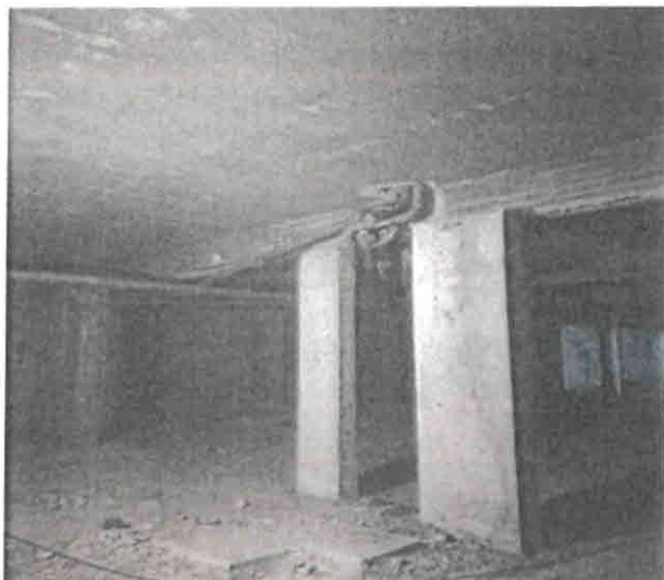
Fotografias n.ºs 15 - Interior da cave, com canalização de esgoto à vista, localizada no piso inferior à garagem do prédio designado "G3 - I - II - III"
