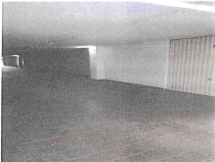
Fotografia n.º 19 e 20 - Garagens individuais, designadas por 2, 3, 4 e 5 do bloco G3 - III com acesso direto ao arruamento a poente
