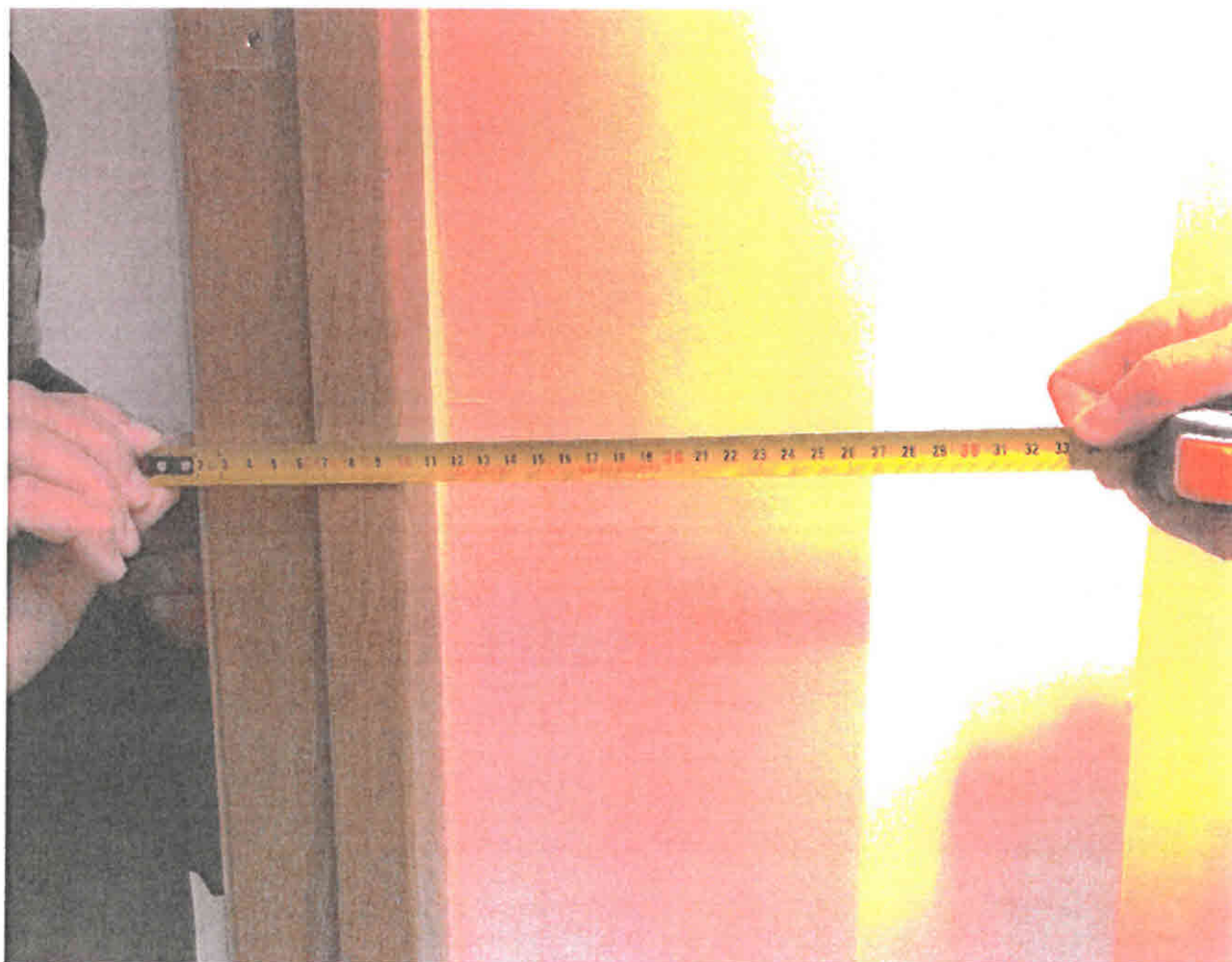
Fotografia n.º 17 - Dimensões da espessura total da parede
