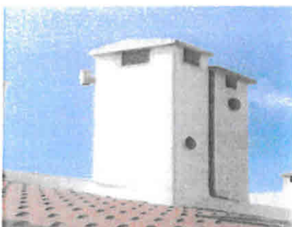
Fotografias n.ºs 23 e 24 – Chaminé que contém os tubos de ventilação dos esgotos da casa de banho
