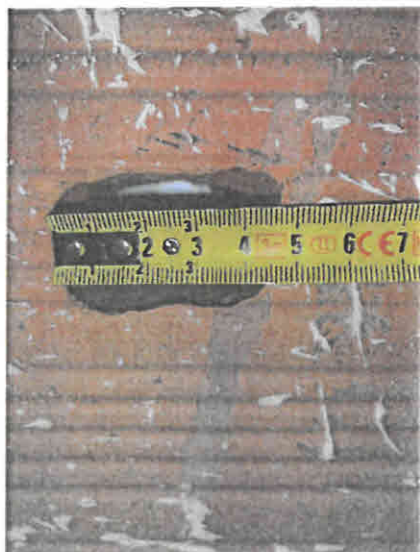
Fotografias 1 e 2 - Dimensões do orifício por medição com fita métrica
