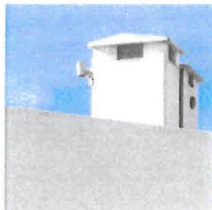
Fotografias n.ºs 23 e 24 – Chaminé que contém os tubos de ventilação dos esgotos da casa de banho
