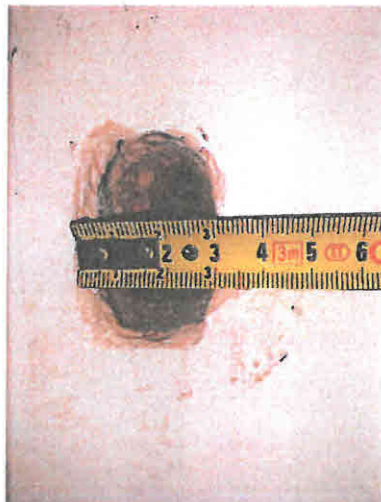
Fotografias n.º 4 e 5 - Dimensões do orifício por medição com fita métrica
