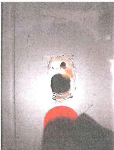
Fotografia n.º 8 e 9 - Observou-se, à vista, revestimento em azulejo cerâmico, reboco e tijolo.
