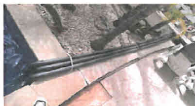
IMAGEM 2 - Após a intervenção
